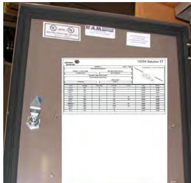
FIG. 3-1 – TERMINATION CHART INSIDE ENCLOSURE DOOR
