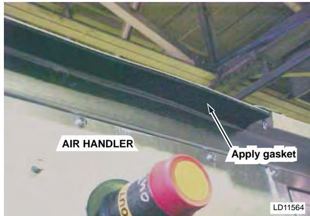
**FIG. 2-41 – INSTALL GASKET UNDER ROOF OVERHANG**
