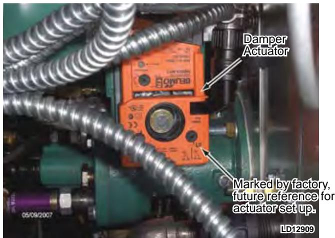
**FIG. 3-19 – DAMPER ACTUATOR**
