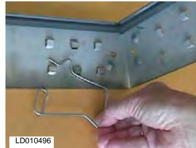
**FIG. 2-104 – INSTALL LATCH P//N 026-35778-007**
